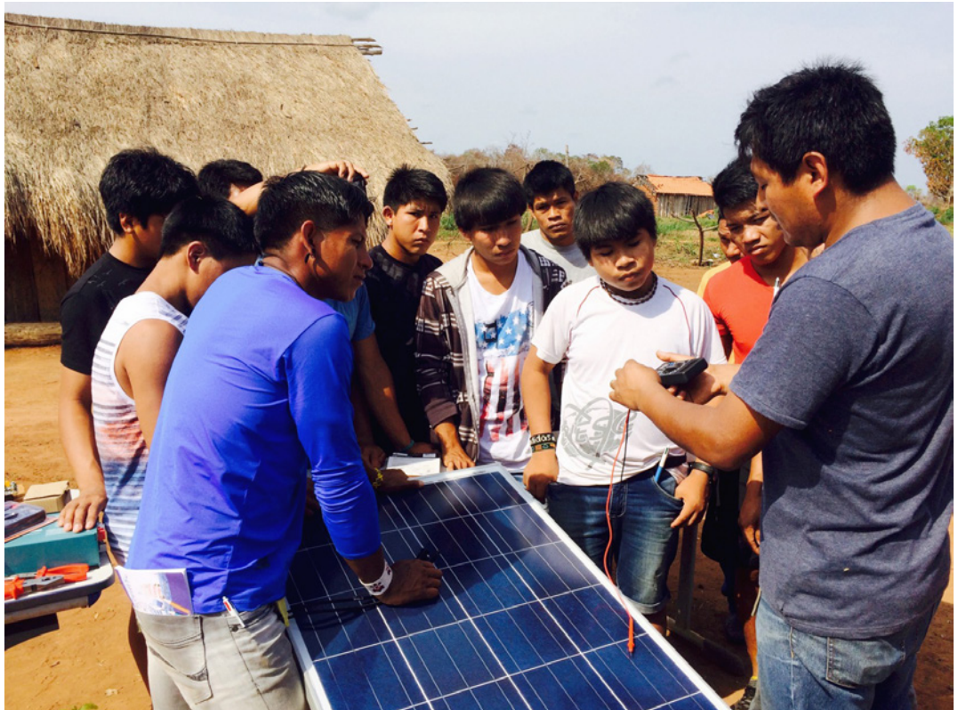
Instalação de placa fotovoltaica durante atividade do curso de energia solar na aldeia Piyulaga, do povo Waurá.
